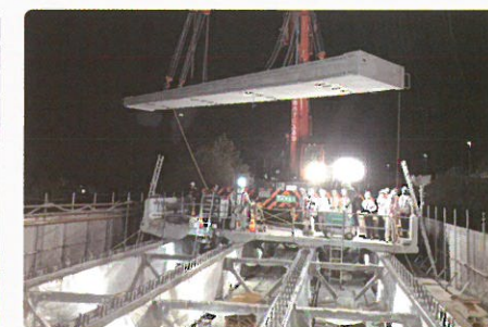
新しい床版の設置の様子
