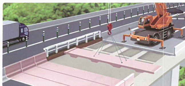
老朽化した床版を撤去し、新しい床版パネルを クレーンで1枚ずつ設置していきます。
